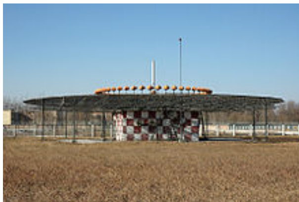
Obrázek 2: Příklad kombinované pozemní stanice D-VOR/DME.
