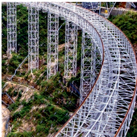
Stavba podpůrné konstrukce. Zdroj: NFRC/FAST.
