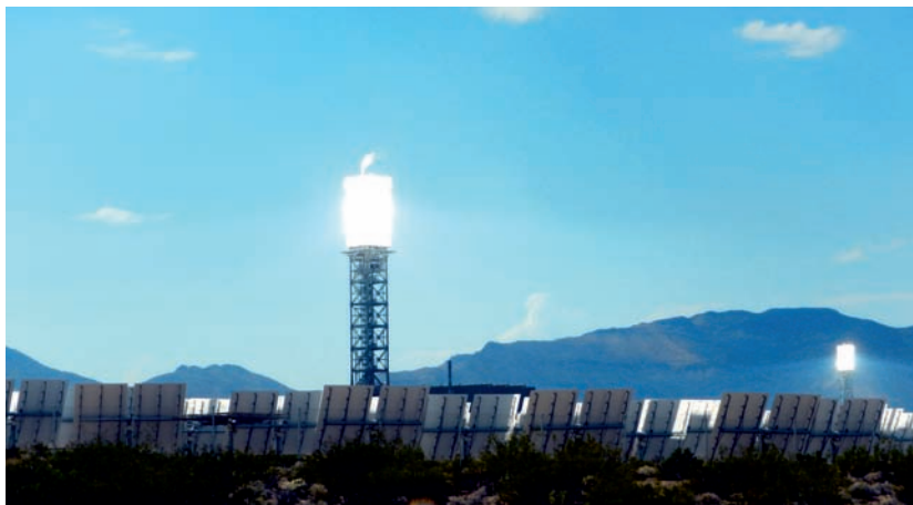
Sluneční věže v Mohavské poušti (Ivanpah Solar Electric Generating System).
