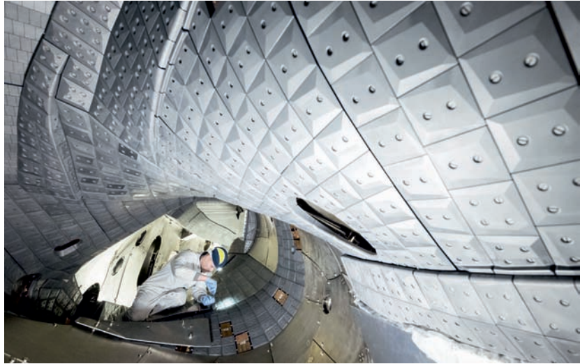
Pohled do vnitřní části komory při jejím pokrývání grafitovými kachličkami. Zdroj: MPI für Plasmaphysik, Jan Michael Hosan, 2017.
