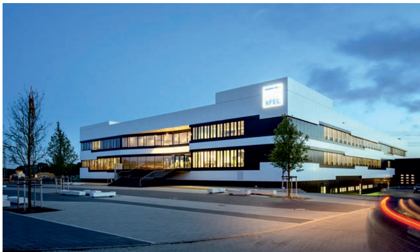
Dnešní podoba nadzemních podlaží experimentální haly. Fotografie je z roku 2017. Zdroj: XFEL/DESY.
